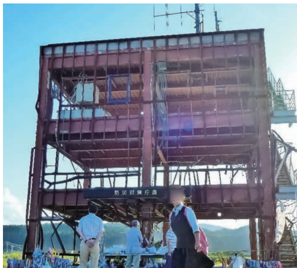
15.5メートルの津波で街が消え、役場庁舎も流失、3階建て防災庁舎の鉄骨だけが残った＝2013年8月25日、宮城県南三陸町、井上昭弘 撮影
